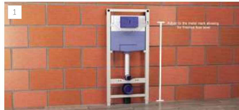
1 Монтаж инсталляции
